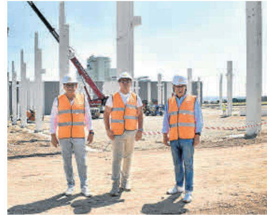
La familia Mena en las obras de ampliación de Ejea.
