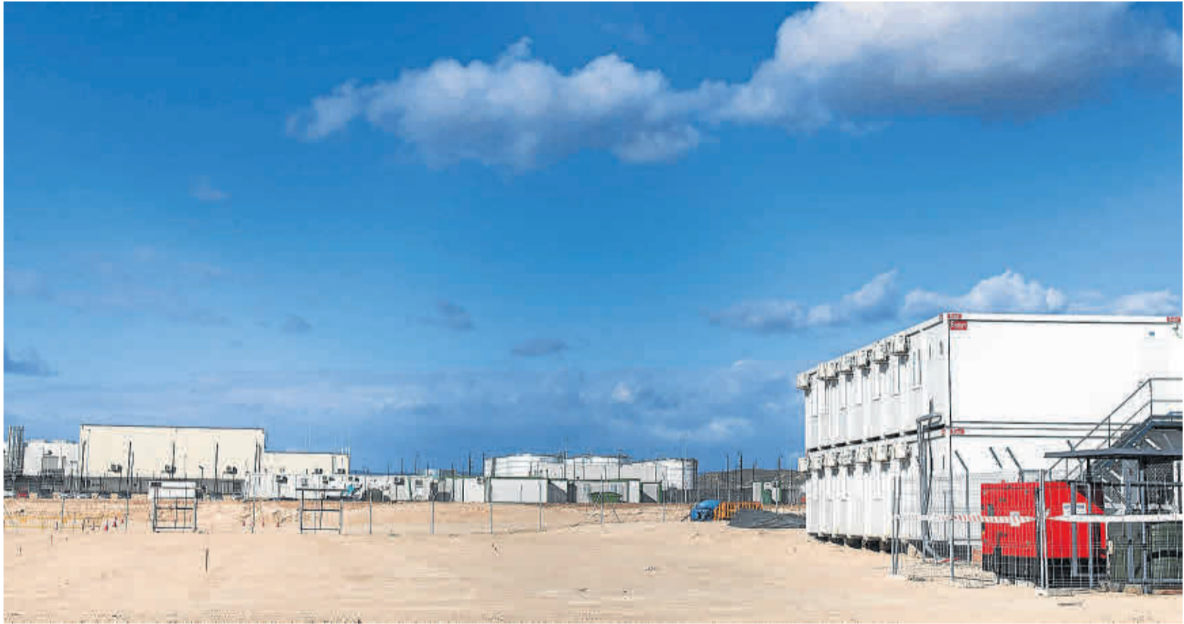
Obras para la construcción de dos centros de datos de AWS junto al que tiene en servicio en Villanueva de Gállego. FRANCISCO JIMÉNEZ
