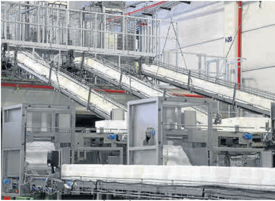
Parte de una de las naves de Bon Área en Épila, que ya está en funcionamiento. RUBÉN LOSADA
