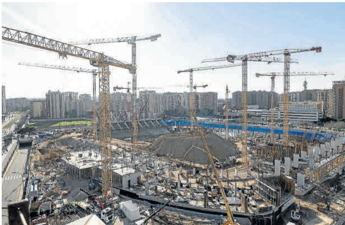
Obras del nuevo estadio de la Romareda, en Zaragoza. GUILLERMO MESTRE
